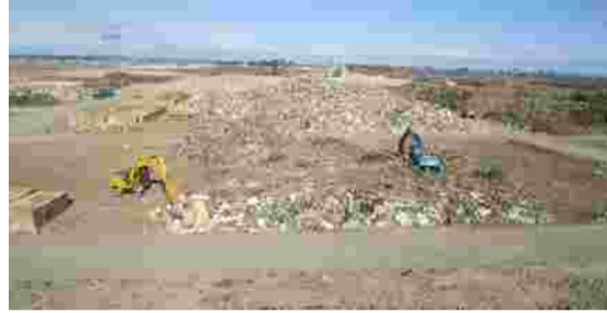
平野部に広い土地を確保したことで処理が進んだ
